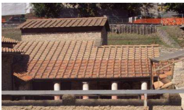
Fig. 19: Portico ovest, manto di copertura in laterizi rossicci.
