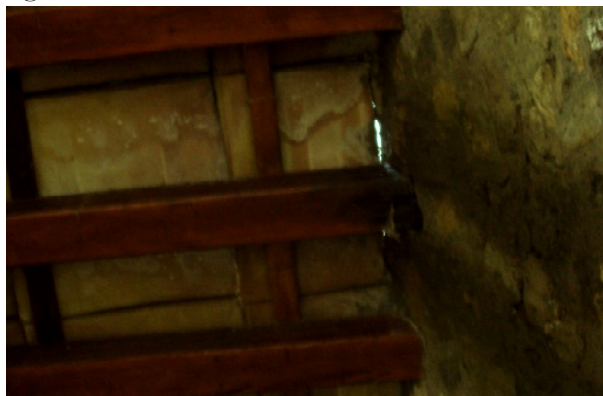
Fig. 11: Torcularium, marcescenza della testa di un travetto
