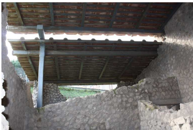
Fig. 26: Vista delle coperture dal Cubicolo Vbis; a sinistra uno dei piedritti verticali (Cubicolo XIII).
