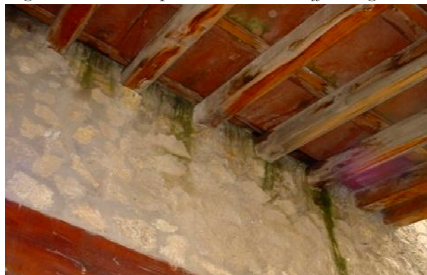
Fig. 12: Portico nord, infiltrazioni dall'attacco alla muratura.
