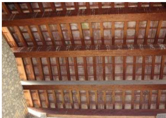
Fig. 15: Deiezioni di volatili sulle travi del Calcatorium.
