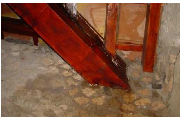
Fig. 8: Deposito, imbibizione delle travi dalla sommità muraria.
