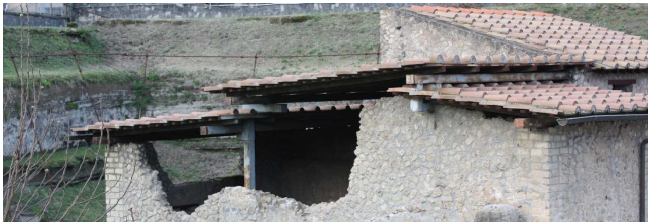
Fig. 25: Quartiere Abitativo Meridionale, vista da est delle coperture a struttura metallica e manto in coppi ed embrici
