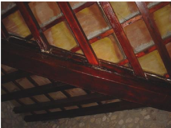
Fig. 23: Deposito, marcescenza della trave di compluvio.
