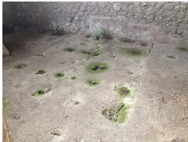
Fig. 29: Cubicolo XIII, gocciolamento d'acqua sul pavimento, presenza di microflora e piante superiori.
